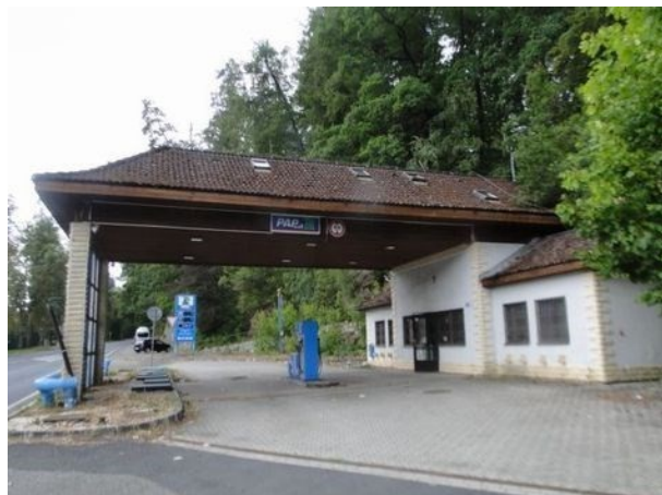
Celkový pohled na čerpací stanici
